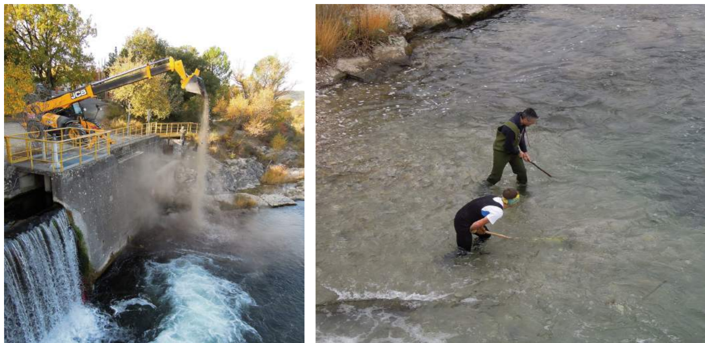
Création d'une frayère artificielle en aval du seuil de Gréoux. Les bénévoles de l'aappma étalent les sédiments.
