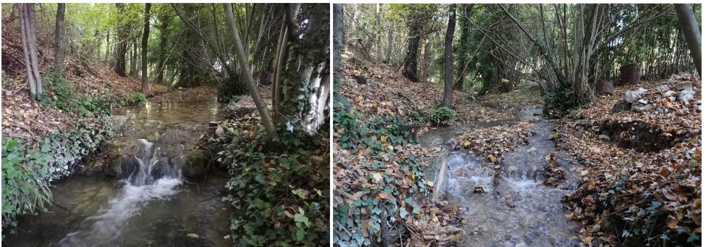
Figure 10 : Aperçu du chenal avant et après démantèlement du seuil (vue de l'aval).
