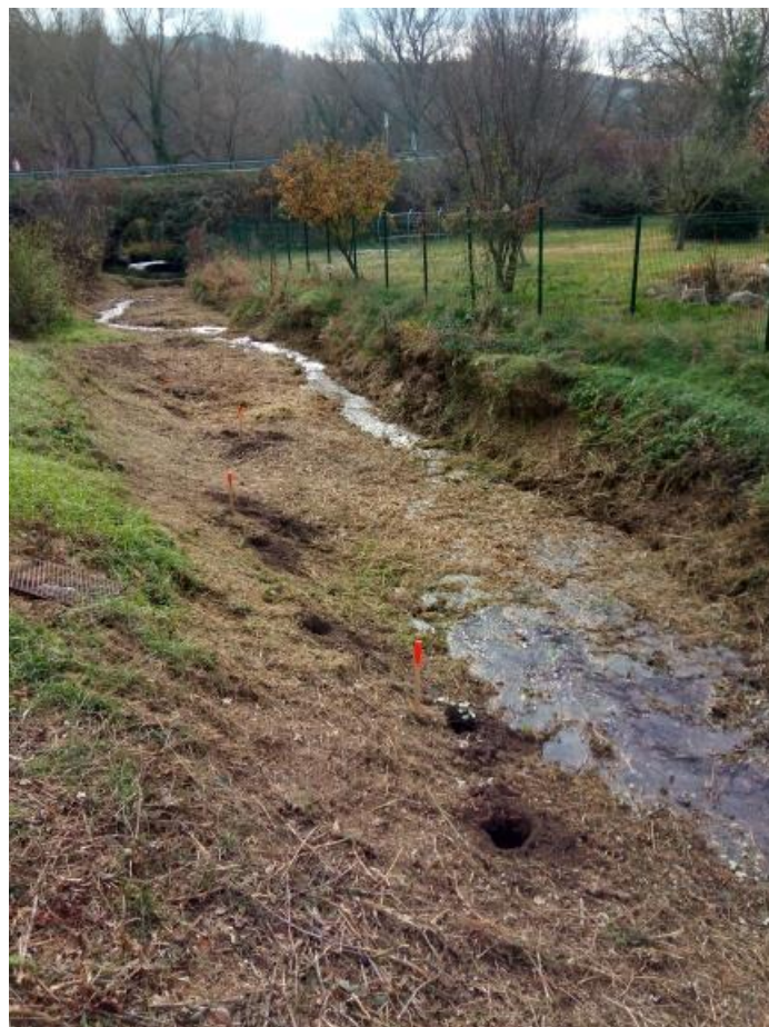
Figure 18 : Mise en place de repères pour cibler les zones à planter..
