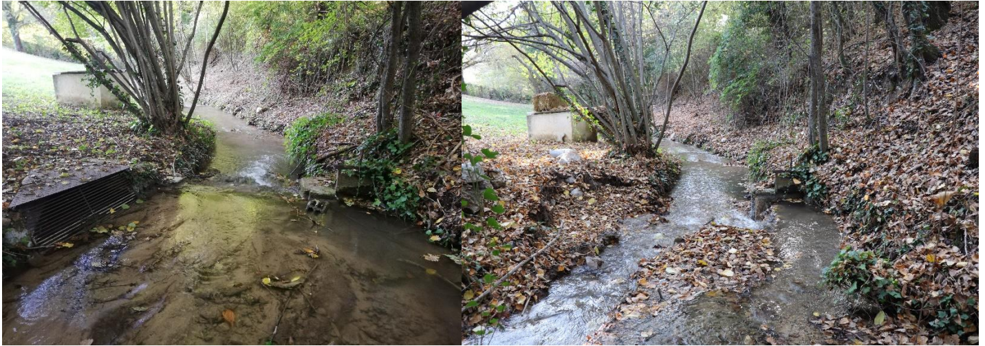
Figure 11 : Aperçu du chenal avant et après démantèlement du seuil (vue de l'amont).
