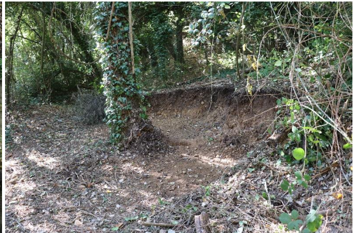
Figure 8 : Zone de prélèvement du remblai.
