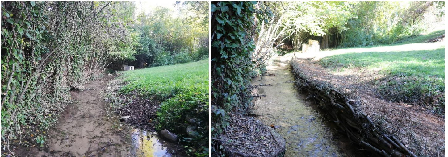
Figure 12 : Aperçu du chenal avant et après aménagement de la berge en technique végétale (vue de l'aval).
