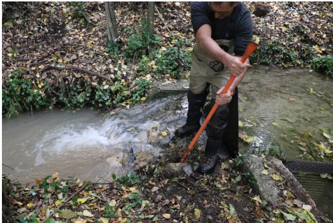
Figure 7 : Démantèlement du seuil.
