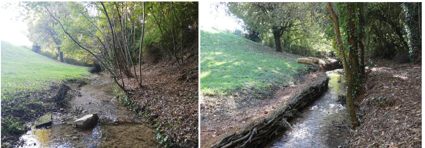
Figure 13 : Aperçu du chenal avant et après aménagement de la berge en technique végétale (vue de l'amont).
